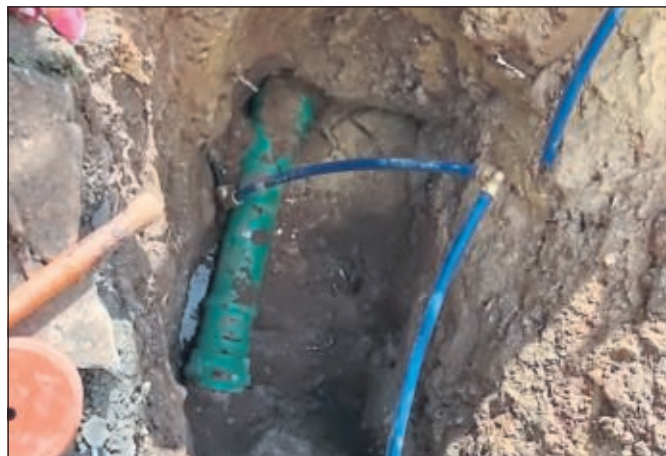
Erneuerung Wasserhausanschluss nach dem Wasserrohrbruch
