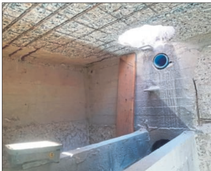
Umbau Regenüberlauf-Bauwerke
